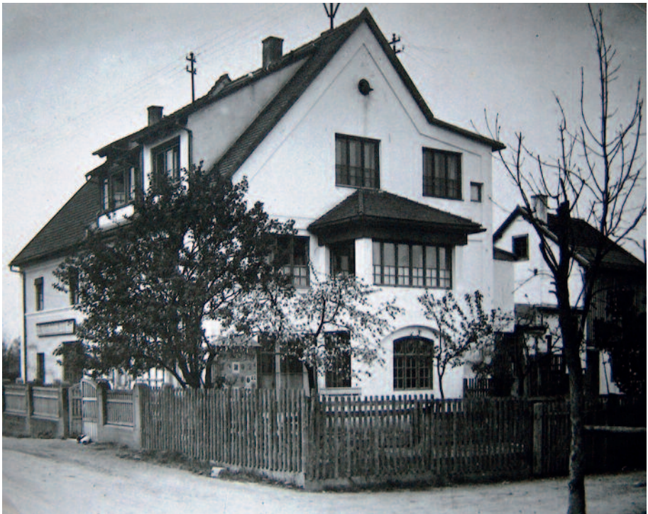
Das Atelier Fenner befand sich in der rechten Gebäudehälfte des Doppelhauses an der Münchener Straße (um 1930)
