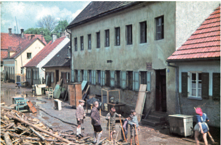
Farbaufnahme vom Pfingsthochwasser 1941, die die Schäden der Anlieger und die Aufräumarbeiten dokumentiert.
