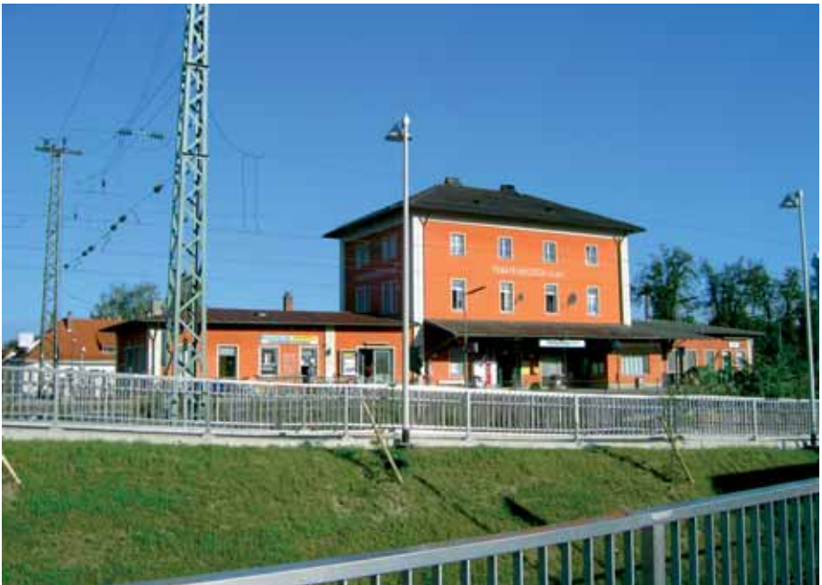
Der Bahnhofsbereich nach Abschluss der Arbeiten (2007)
