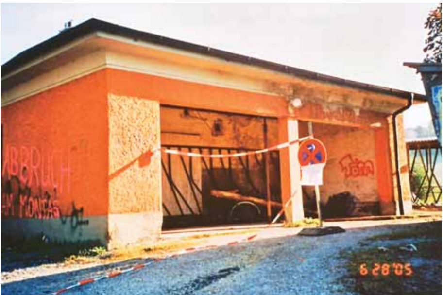
Abbruch der Fahrradeinstellhalle (2005)
