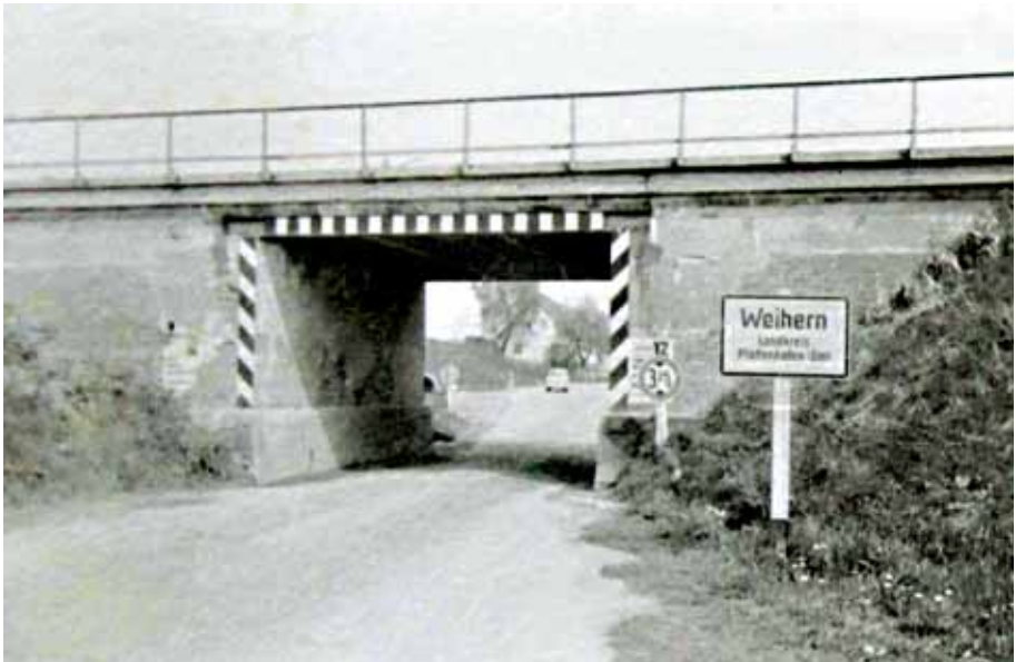
Die alte Weiherer Unterführung mit der berühmten Senke, die bei Starkregen eine 30 Zentimeter tiefe Pfütze bildete und den Autoverkehr behinderte [1967].
