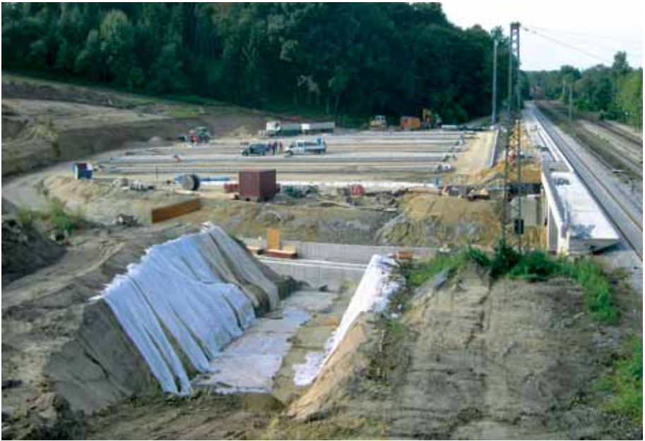
Anlage eines neuen großen Parkplatzes auf der Ostseite des Bahnkörpers (2006)
