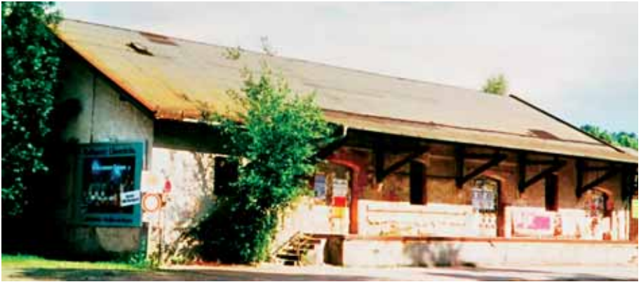
Die Güterhalle kurz vor ihrem Abbruch 2004
