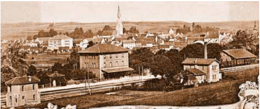
Der Bahnhof mit den seitlichen Anbauten aus dem Jahr 1901 und dem 1891 errichteten südlichen Stellwerk, das nach dem zweispurigen Ausbau notwendig wurde (Ansichtskarte, ca. 1910)
