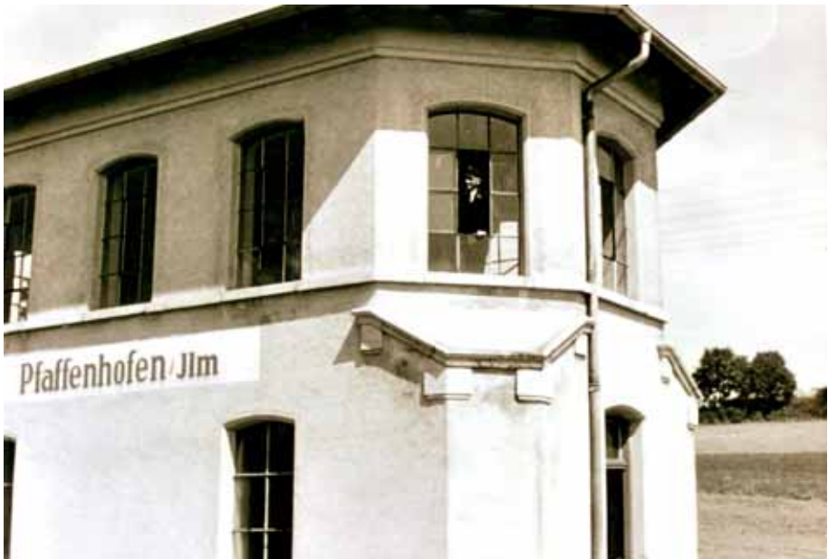
Das mechanische Stellwerk südlich des Bahnhofs war bis 1962 in Betrieb (ca. 1955)
