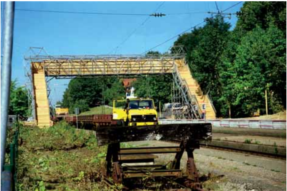
Die gewagte Holzkonstruktion für die Pendler, die in rund 7,50 Metern Höhe die Gleise überqueren mussten, blieb sechs Jahre in Gebrauch (ca. 2001).
