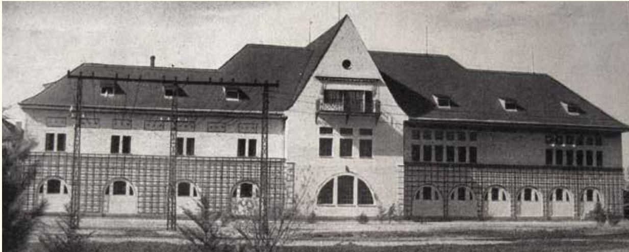
Das Schalthaus der Amperwerke im Jahr 1925
