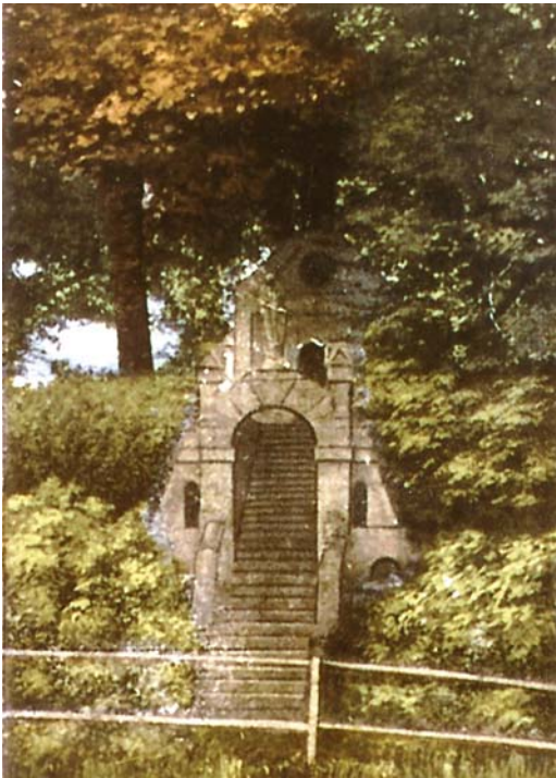
Der frühere Aufgang zum „Kireindl“ mit Torbogen, der später abgetragen wurde (undatiert)
