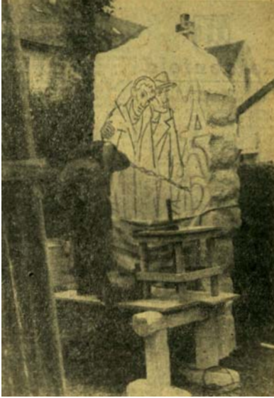
Vorbereitung des Denkmals für die Einweihung im Juli 1957
