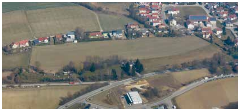
Das neue Baugebiet „Heißmanning-Weingartenfeld“ am nördlichen Stadtrand
