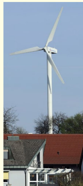
Auf ein verträgliches Nebeneinander von Windenergieanlagen und Wohngebäuden muss geachtet werden. Der Windenergieerlass Baden-Württemberg sieht für die Regionalplanung und die Flächennutzungsplanung einen Vorsorgeabstand von 700 m zwischen Windenergieanlagen und Wohngebieten vor. Abweichend davon können sich in der Einzelfallbetrachtung deutlich höhere, aber auch niedrigere Abstände ergeben.
