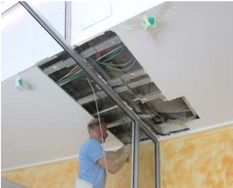
Brandabschottung von Kabeldurchgängen (2016)
