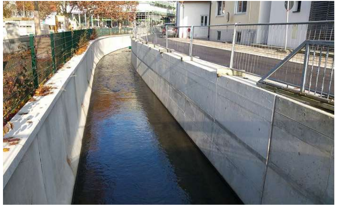
Stützwand: Sommer 2015 – Frühjahr 2016
