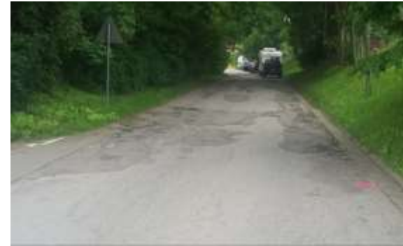
Straßenbau Förnbach Eichenweg ca. 1000m 2
