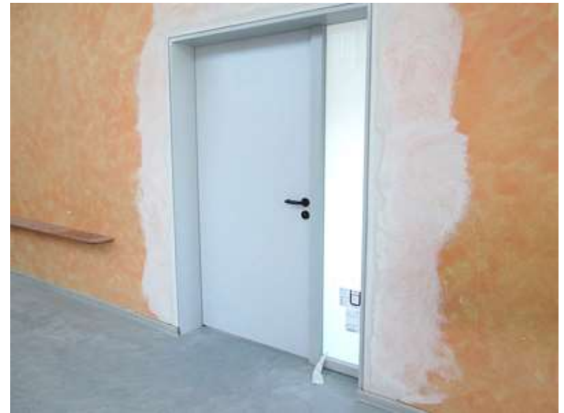
Nachrüsten von Brand- und Rauchschutztüren (2016)
