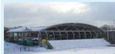
Ihre mit Abstand größte Photovoltaikanlage hat die Stadt Pfaffenhofen auf dem neuen Dach des Eisstadions in Betrieb genommen. Mit einer Modulfläche von 1.568 Quadratmetern und einer Gesamtleistung von 235,2 KWp ist die neue PV-Anlage mehr als zehnmal so groß wie die bisherigen Anlagen auf der Dreifachturnhalle der Volksschule oder auf dem Dach der Kindertagesstätte Ecolino.
