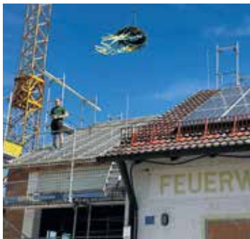
Den Richtspruch sprach Zimmerer Hofbauer.
